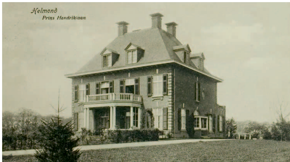
Prins Hendriklaan 25. De door Hanrath voor H.L. Fentener van Vlissingen gebouwde villa, 1915 - 1917. Ansichtkaart, collectie RHCE 02415.
